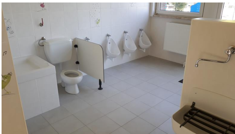
Vues après travaux
