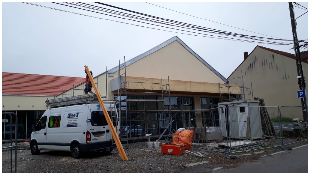
Pose du brise-soleil et du crépi.
