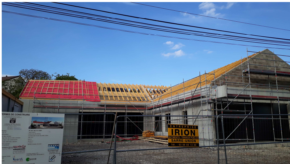
Mise en place de la charpente.
