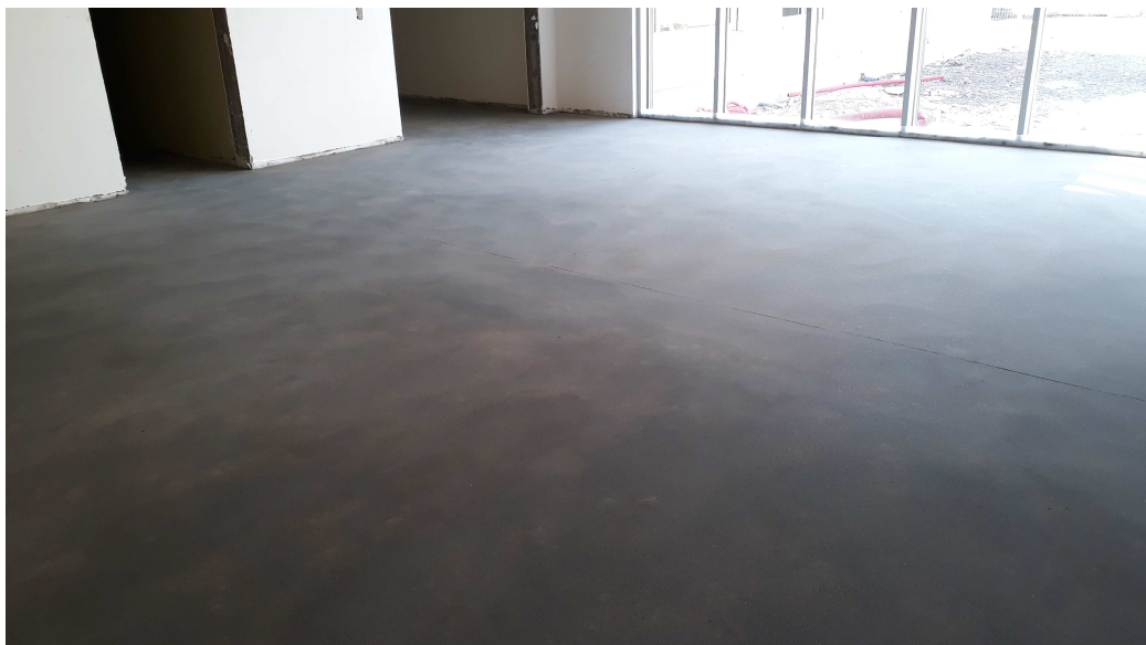
Pose de la chape.
