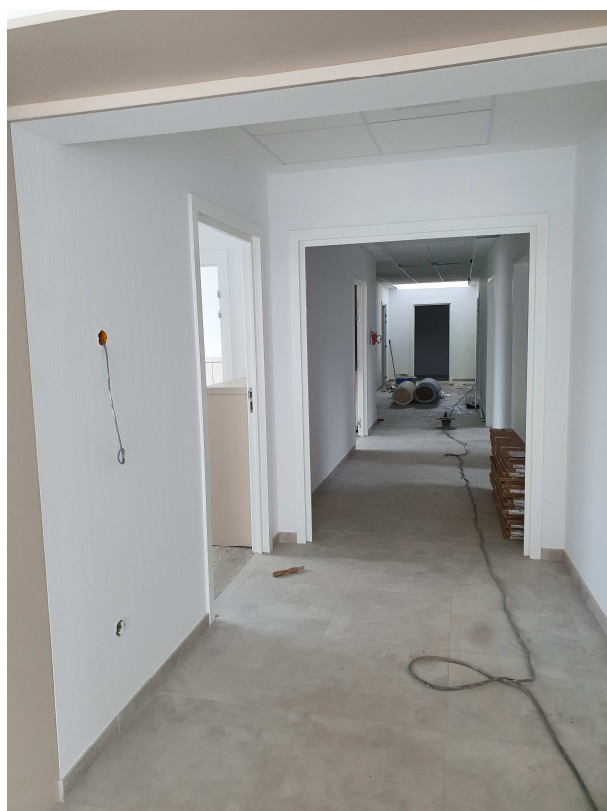
Pose des revêtements (murs et sol).
