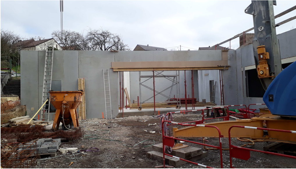
Pose des prés-murs côté Nord-Ouest.
