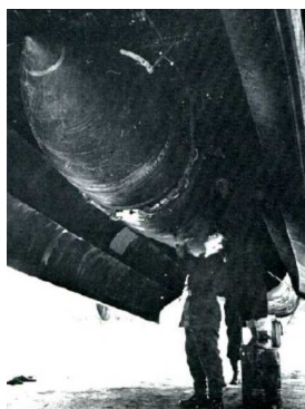
(une Tallboy dans la soute d'un Lancaster. Les dimensions exceptionnelles de cette bombe avaient imposé une modification profonde des portes de la soute, et y interdisaient toute installation de réservoirs supplémentaires)
