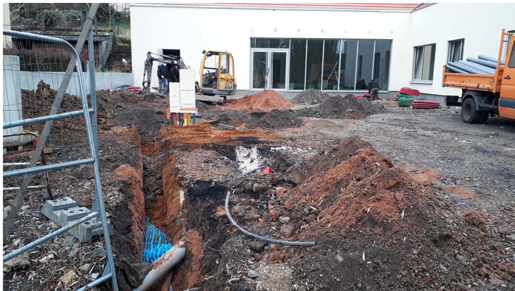
Pose et raccordement des fluides et des évacuations d'eaux sanitaires et pluviales.
