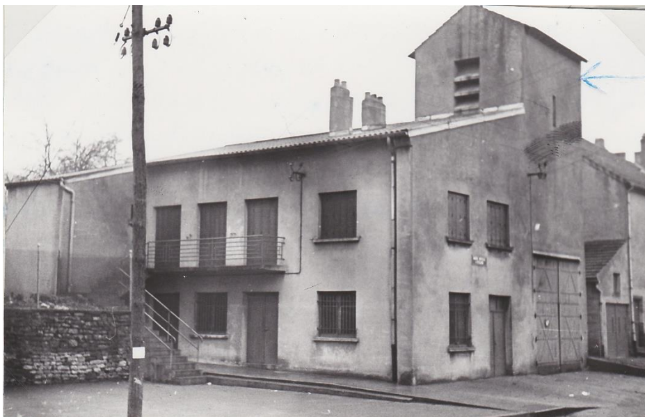
Le bâtiment du crédit mutuel réhabilité.
