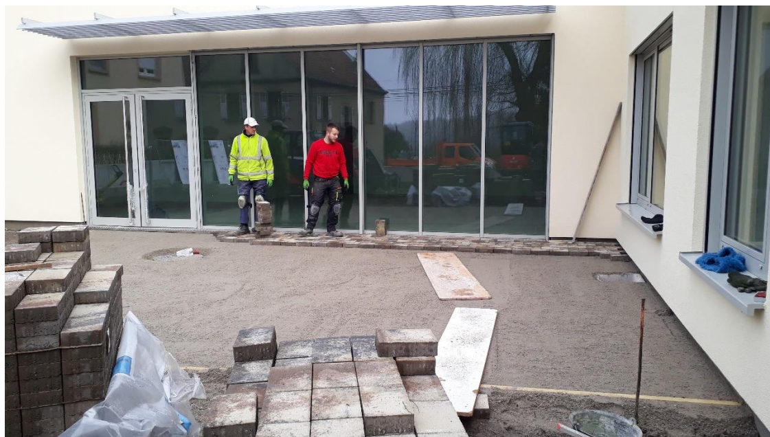
Pose d'autobloquants sur le parvis de la salle du conseil.
