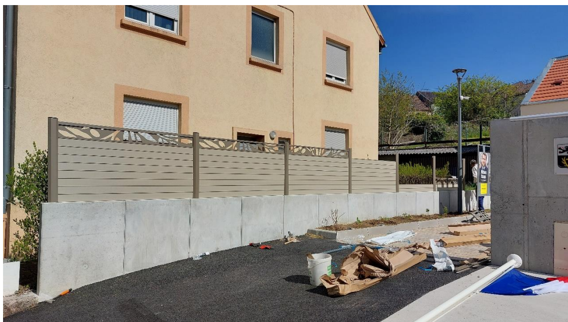
Pose d'une palissade en limite de propriété.
