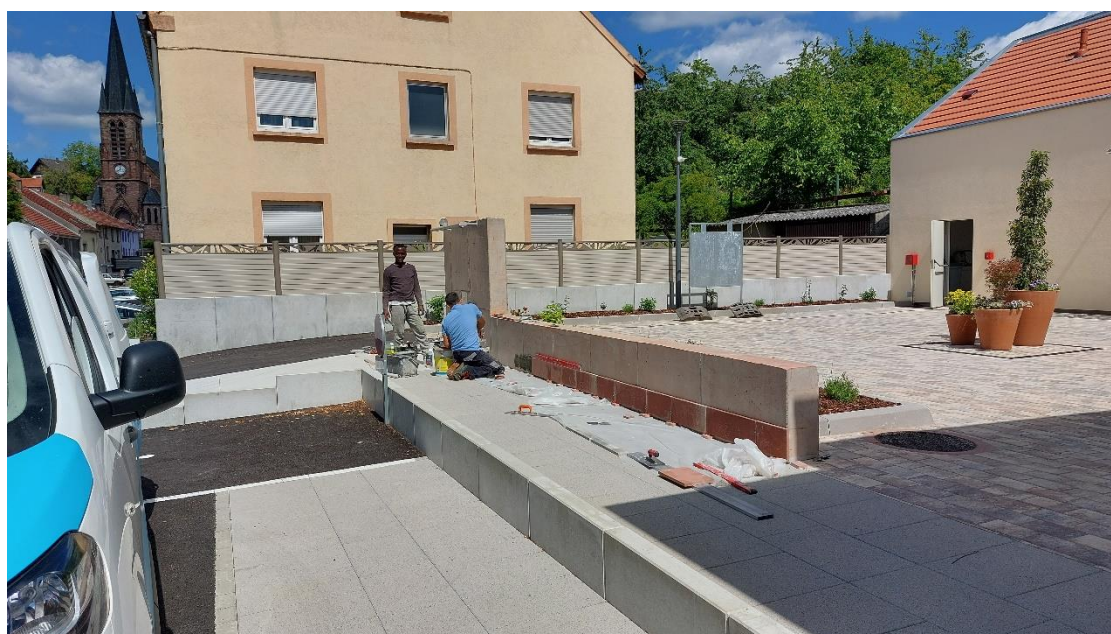
Habillage du mur séparatif avec des dalles en gré de Vosges.
