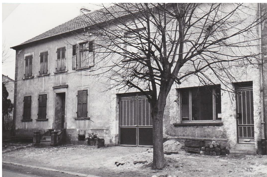
L'agence installée dans la maison de SCHNEIDER.
