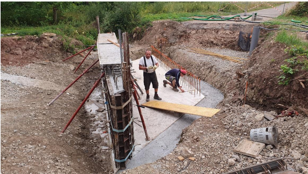
Construction des murs de soutènement.
