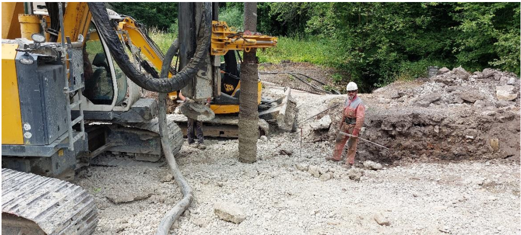
Mise en place des micropieux afin de stabiliser l'édifice.
