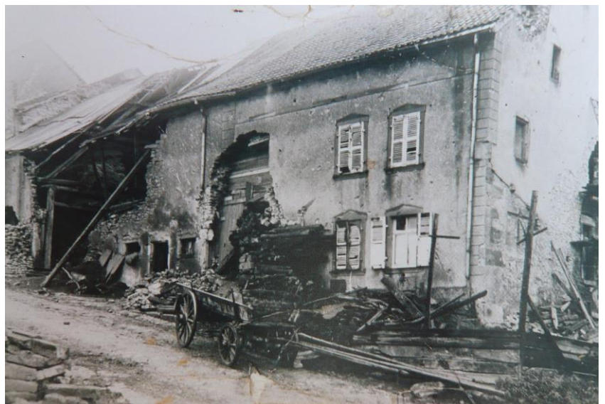
Vue des dégâts occasionnés à la maison GREFF( rue du Lavoir)
