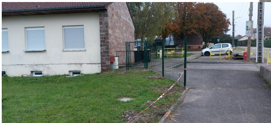
Mise en place d'une nouvelle clôture à l'avant du logement de l'école élémentaire.
